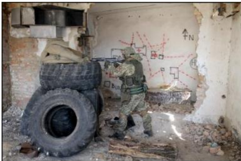
Рисунок 8.45 – варіант обладнання бійниці з підручного матеріалу (вигляд зсередини).
