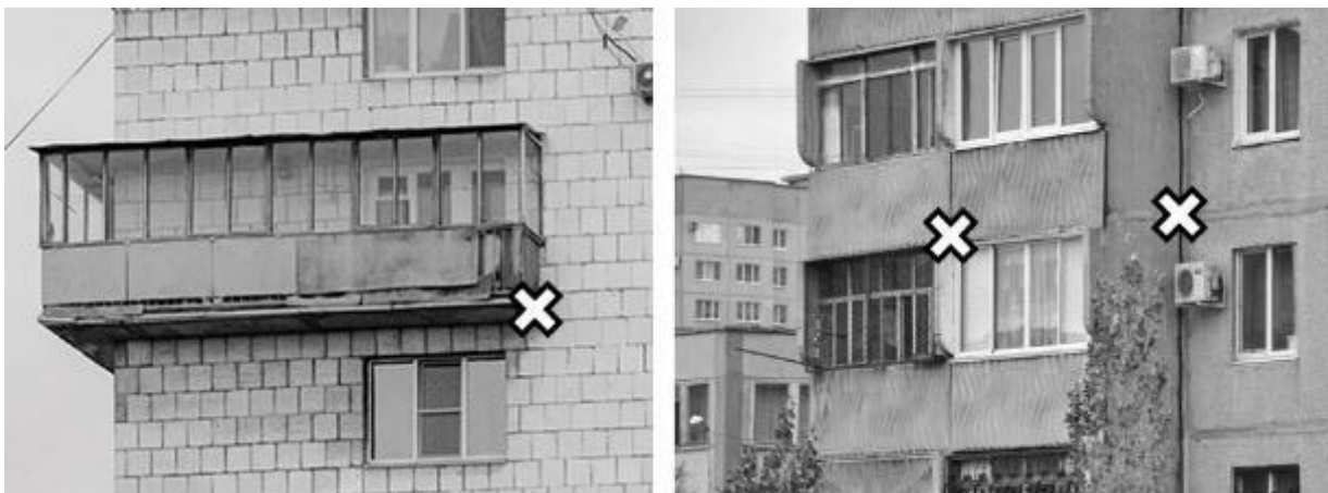
Рисунок 8.49 – місця технологічних кріплень та стикувальних вузлів багатоповерхових будинків.
