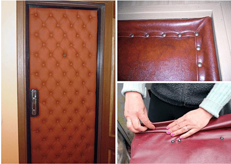
Рис.20 Технологія оббивки дверного полотна дерматином
