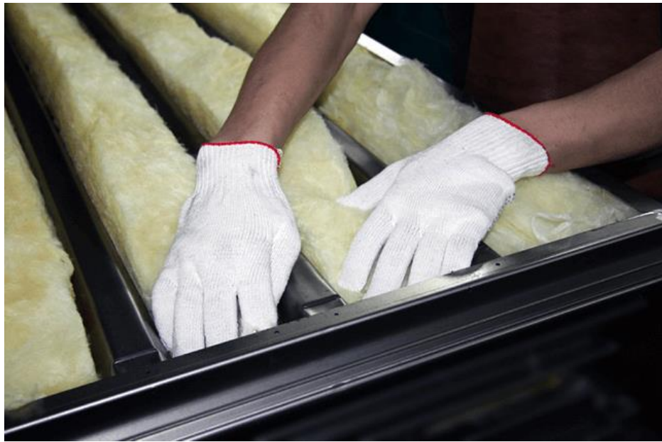
Рис. 19 Утеплення металевих дверей
