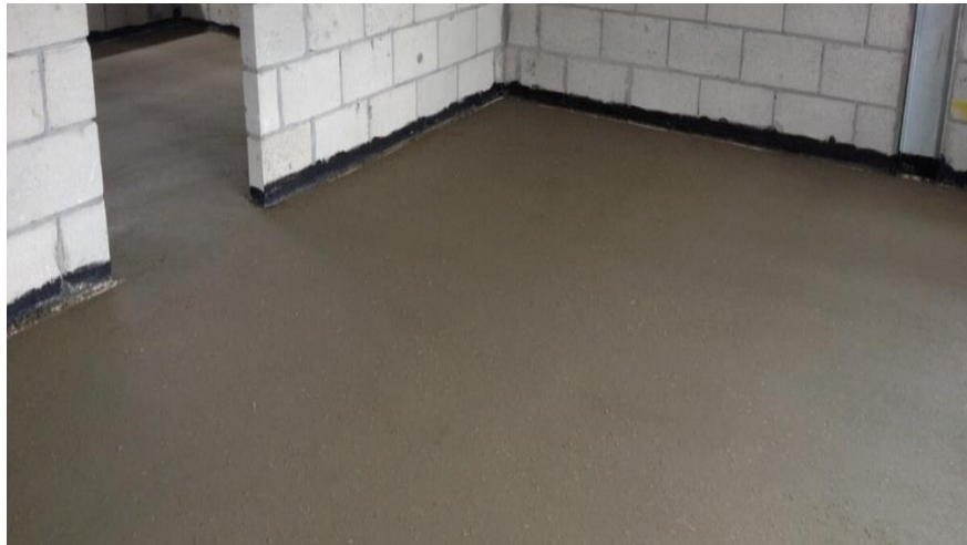
Рис. 28 Утеплення бетонної підлоги
