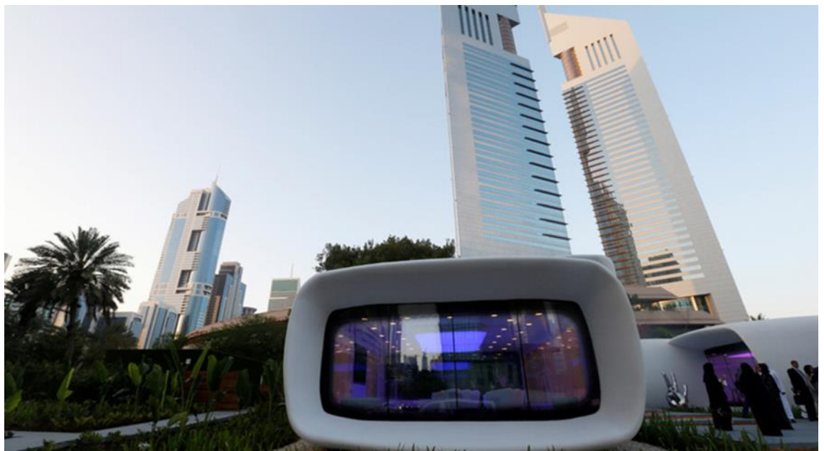
Рис.3 Офіс Future Emirates Foundation. Майбутній будинок в Об'єднаних Арабських Еміратах, який побудований на 3D-принтері.
