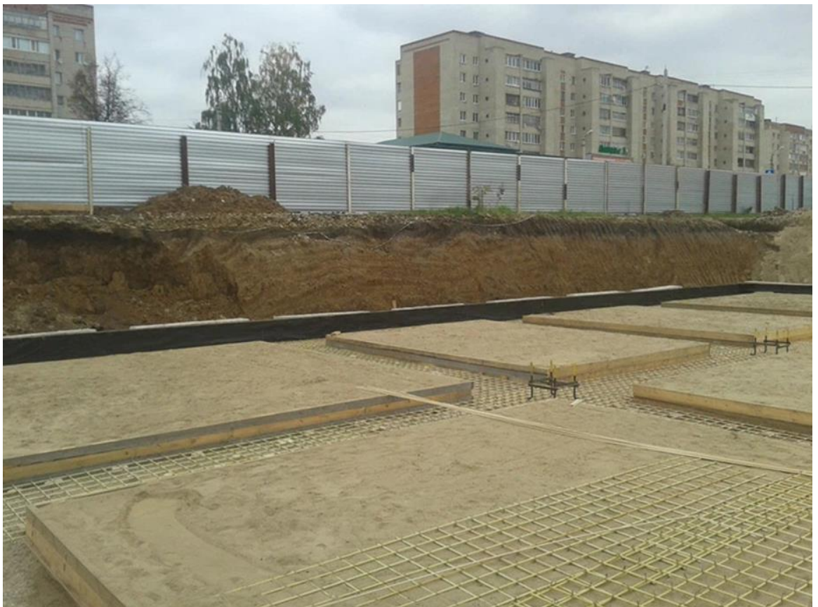
Рис.3 Впровадження склопластикової арматурної сітки
