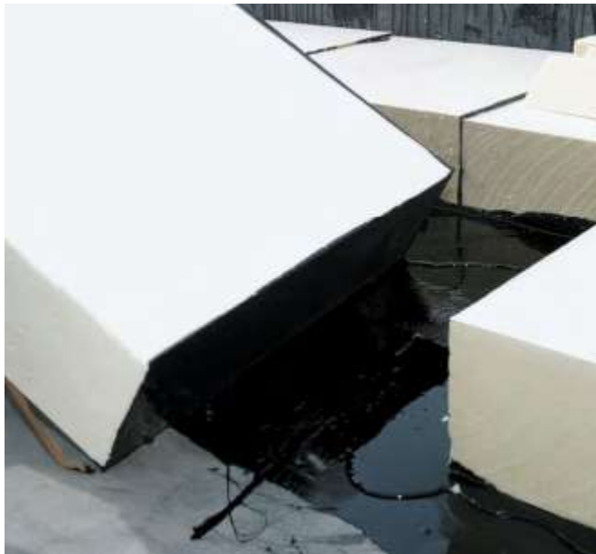
Рис.2.6 - Наклеювання теплоізоляційних плит
