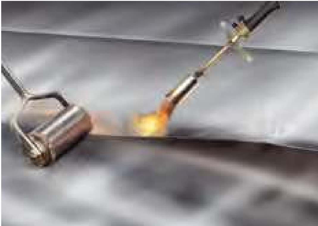
Рис. 2.2 - Вільне укладання матеріалу зі зварюванням швів
