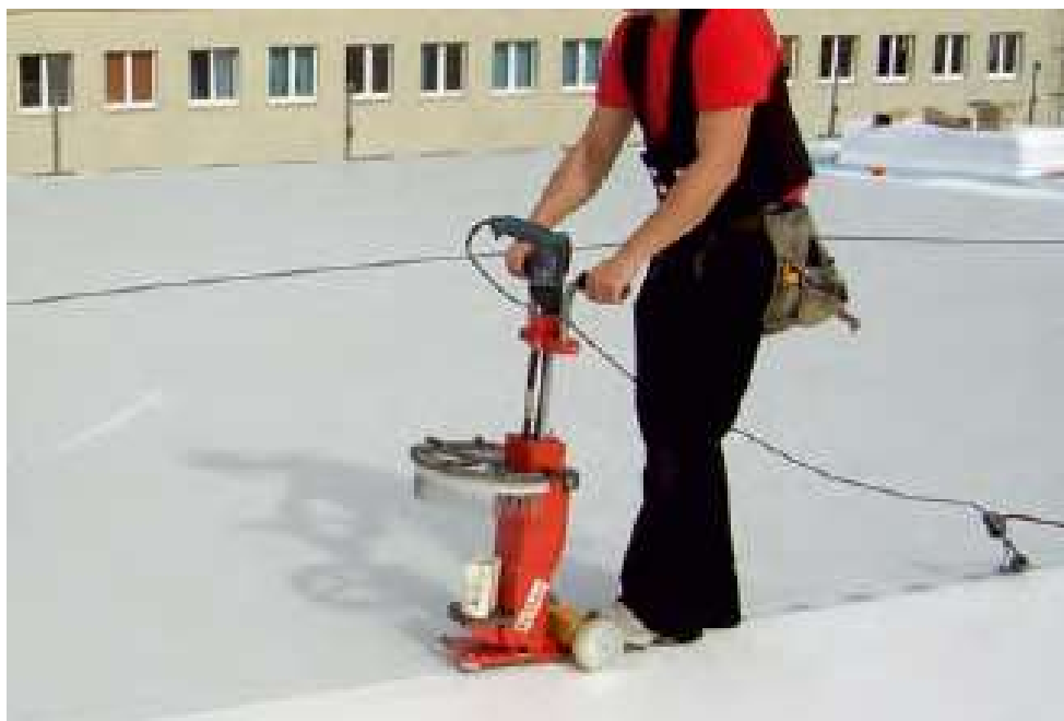
Рис. 2.28 - Індукційний методі кріплення полімерної мембрани
