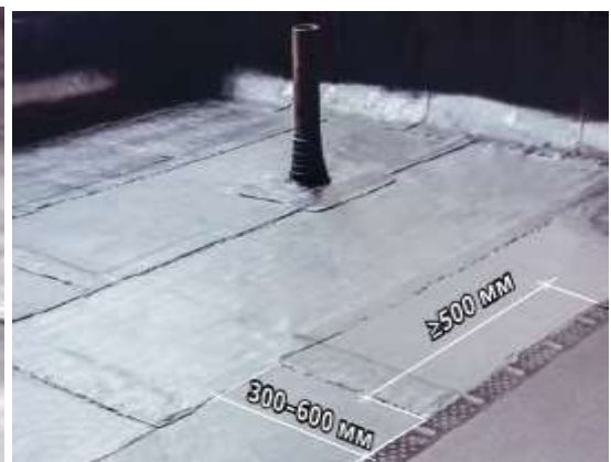
Рис. 2.20 Напуски полотнищ рулонних матеріалів при укладанні методом приклеювання
