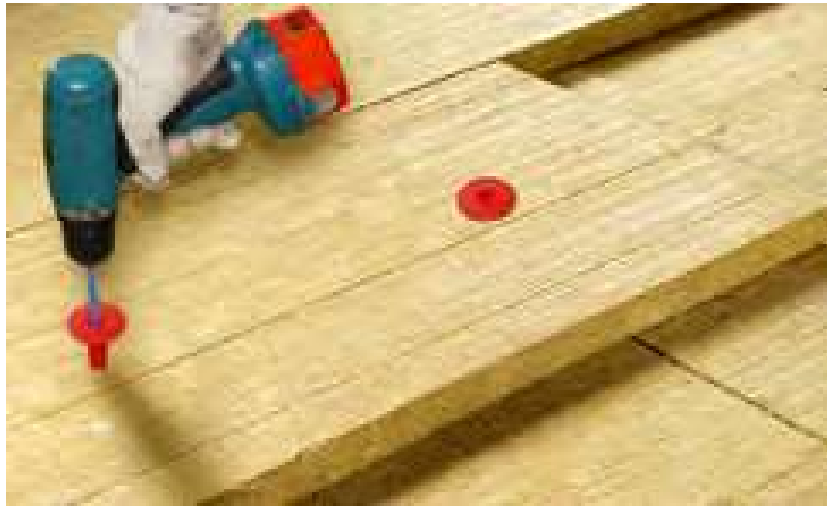
Рис.2.7 - Механічне закріплення теплоізоляційних плит
