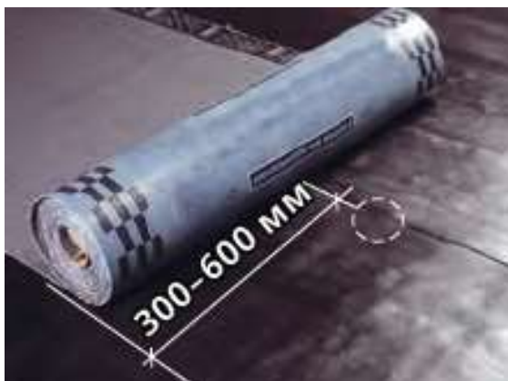
Рис. 2.20 Напуски полотнищ рулонних матеріалів при укладанні методом приклеювання
