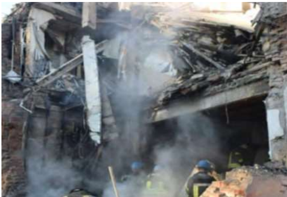
Рисунок 1.6 - Масштабні руйнування будинків
