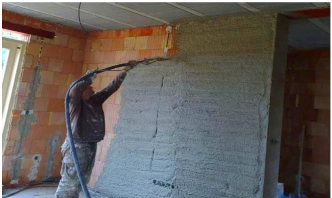
Рис. 17 Оздоблювальні роботи за допомогою механізації
