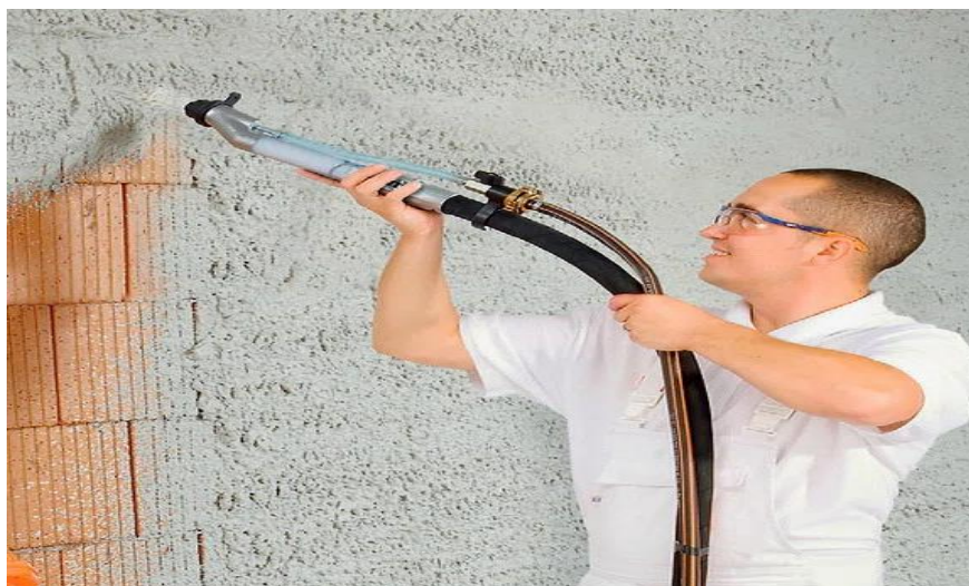
Рис. 18 Оздоблювальні роботи за допомогою механізації
