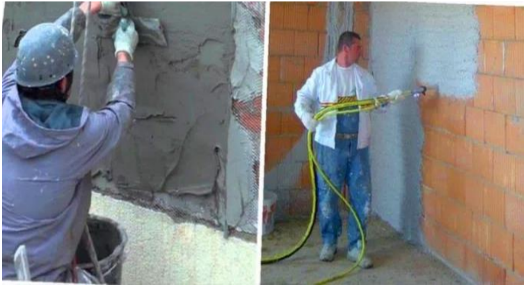
Рис. 16 Машинне штукатурення
