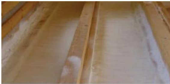
Рис.19 Утеплення пінополіританом. Утеплення горища мінераловатними плитами
