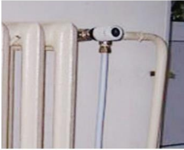
Рис. 9 Облаштування терморегулятора на існуючому радіаторі
