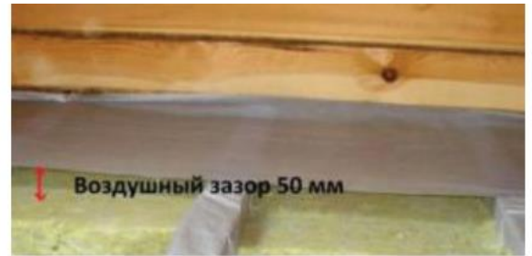
Рис.19 Утеплення пінополіританом. Утеплення горища мінераловатними плитами
