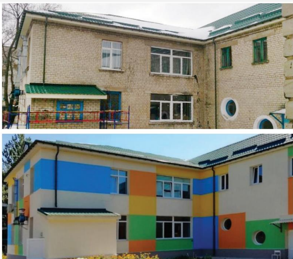
Рис. 13 Будинок до та після утеплення.
