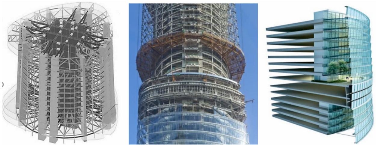
Рис. 6 Конструктивне рішення каркасу будівлі
